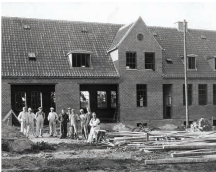
Brovst Autocentral under opbygningen i 1935
